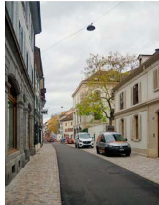
Zu breite Pflasterstreifen an der St. Alban-Vorstadt (und auch an der Rittergasse) verleiten zum Parkieren.
