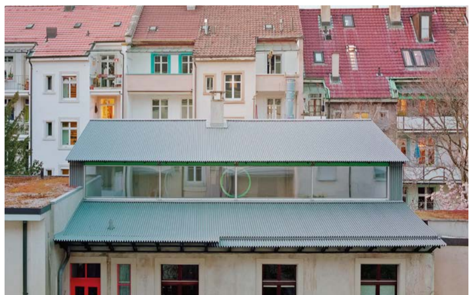
Aufgestockte Werkstatt im Hinterhaus an der Matthäusstrasse 7
